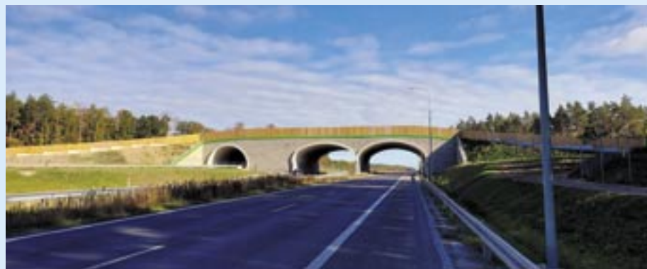
Przejście górne droga ekspresowa S5.
