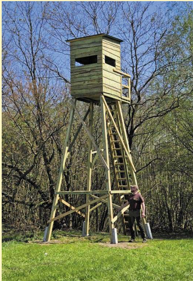
Jacek Pielichowski przy budowie ambony.
